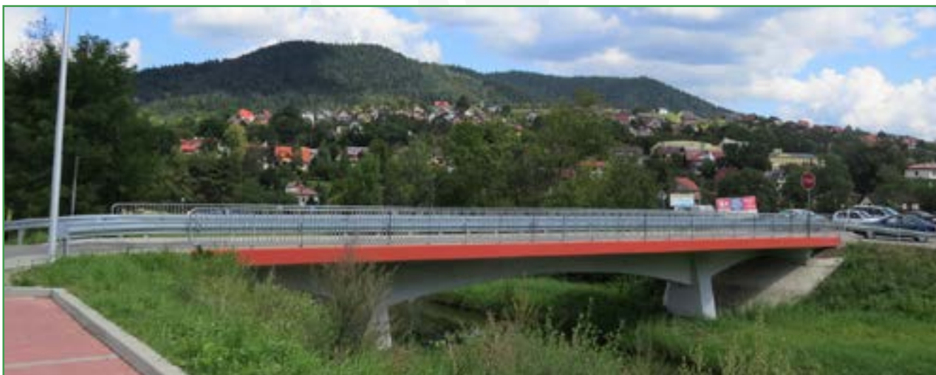
Most w ciągu ul. Szwedzkiej
