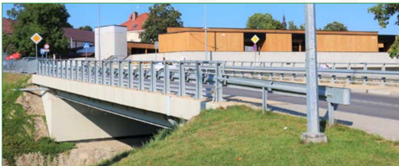
Most w ciągu ul. Targowej
