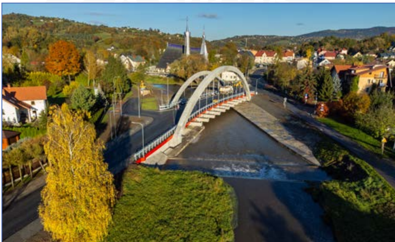
Most w ciągu ul. Lipowej
