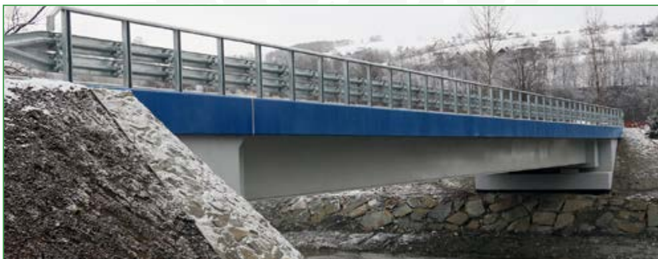
Most w ciągu ul. Dudka
