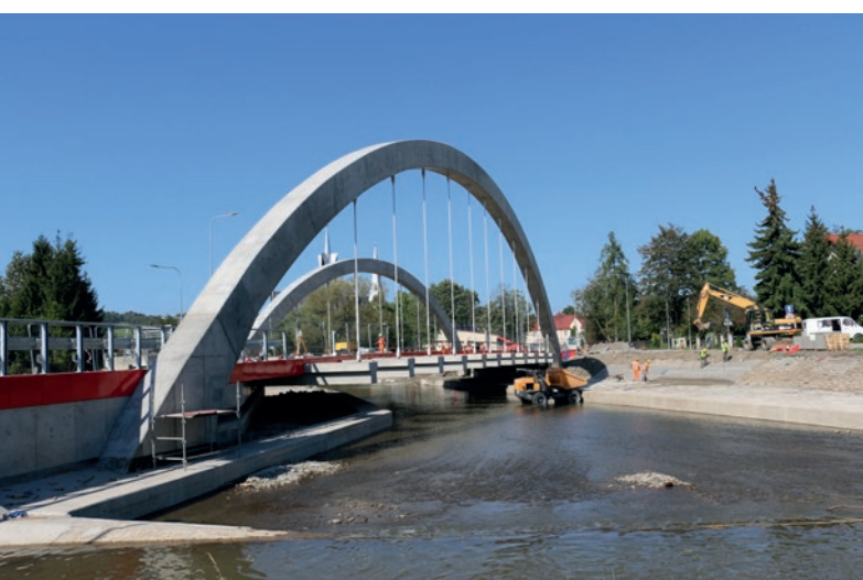
Budowa mostu w ciągu ul. Lipowej – roboty postępują – str. 5
