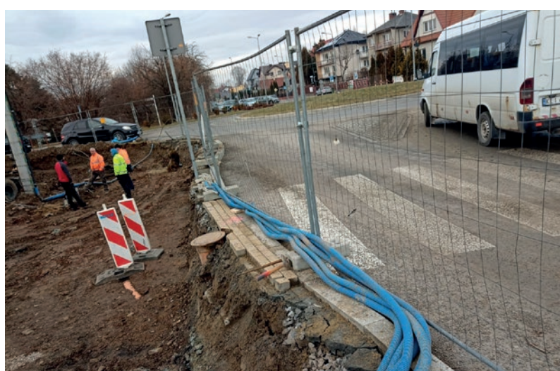
Rozpoczęła się budowa nowego dworca str. 7
